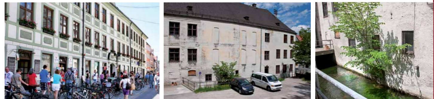
Lieb gewonnener Anblick: Die Fassade des Asamgebäudes entlang der Hauptstraße. Weniger ansehnlich: die Rückseite. Nun soll der Hinterhof zum einladenden Platz werden, auch Bett und Uferbefestigung der Moosach werden saniert. Bilder: MASELL (3)
