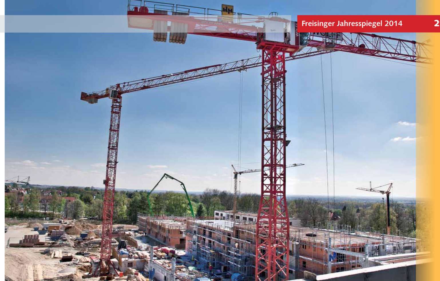
Rund geht es auf den Baustellen im SteinPark. Die ersten Häuser und Wohnungen werden noch heuer bezogen. Für den zweiten Bauabschnitt ist bereits der Startschuss gegeben. Leben werden in dem Viertel einmal 1000 Menschen. Bild: MASELL
