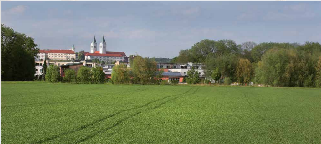
Die Seilerbrücklwiesen am südlichen Stadteingang stellen mit einer Fläche von etwa 85 700 Quadratmetern ein bedeutendes Entwicklungspotenzial dar. Vorgesehen sind dort eine Wohnbebauung für Familien und Studentenappartements, eine Tagesstätte mit Krippe, Kindergarten und Hort. In dem Wohnquartier werden einmal mehr als 500 Menschen leben. Bild: MASELL
