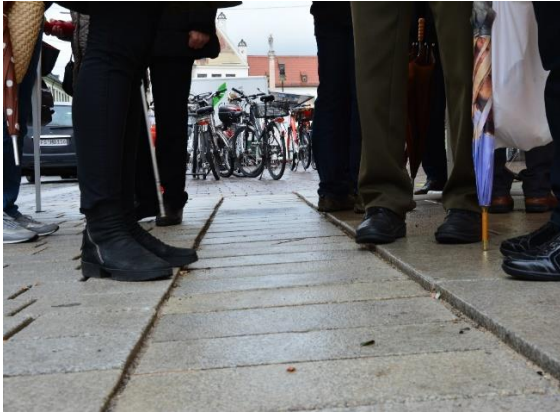
Gerundete Kante entlang der Entwässerungsrinne, Höhe ca. 1,5 cm und Bojensteine (visueller Kontrast) entlang der Hauptstraße
