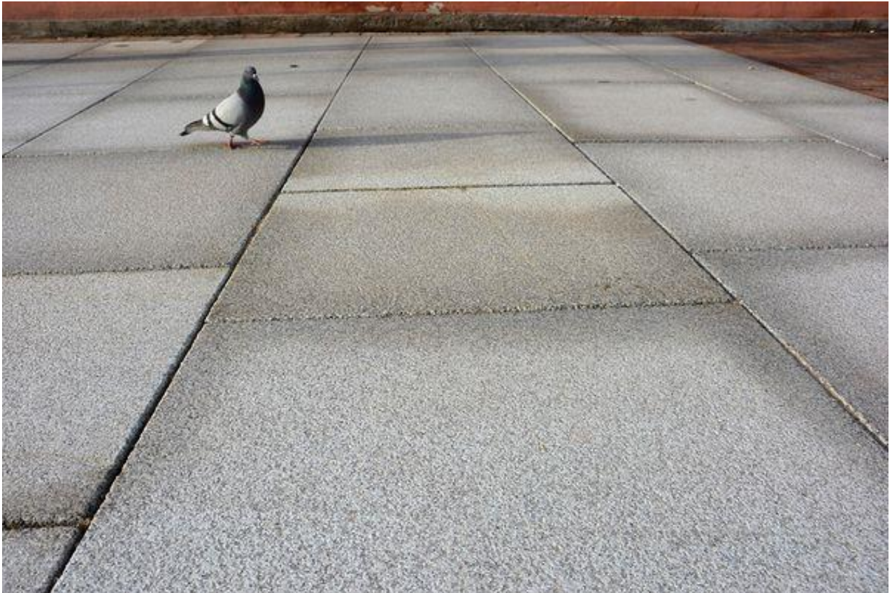
Ebene, rutschsichere Natursteinbeläge aus Granit (Pflaster- und Plattenbelag, SRV „wet“ von min 70, ungebunden), Beschluss vom 16.12.2015
