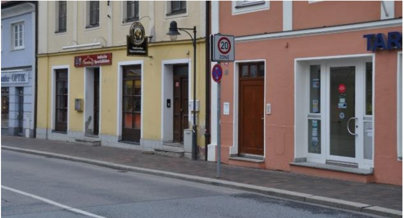
Nicht barrierefreie Gebäudeanschlüsse
