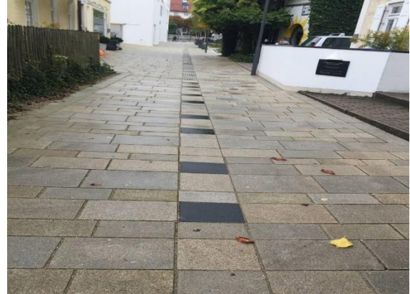
Gerundete Kante entlang der Entwässerungsrinne, Höhe ca. 1,5 cm und Bojensteine (visueller Kontrast) entlang der Hauptstraße
