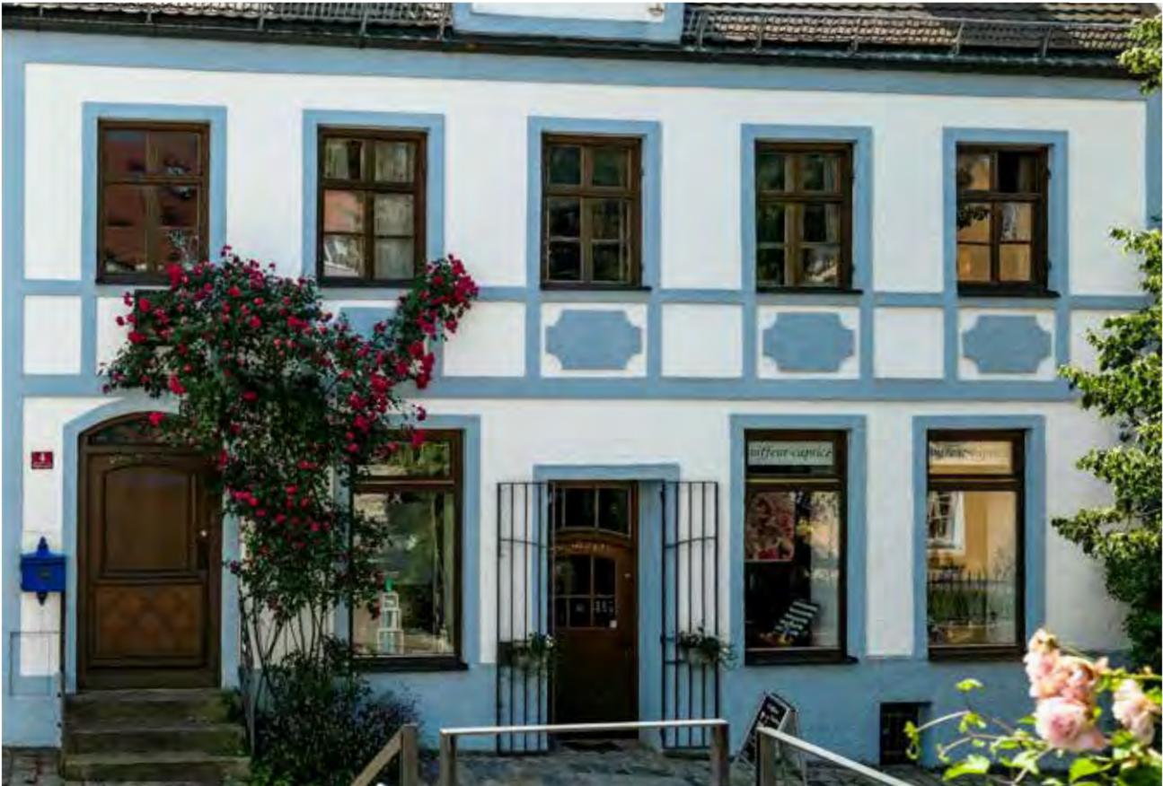
Erdgeschosszone durch verputzte Mauerwerksockel und Wandpfeiler in „Schaufenster“ und Eingang gegliedert.
