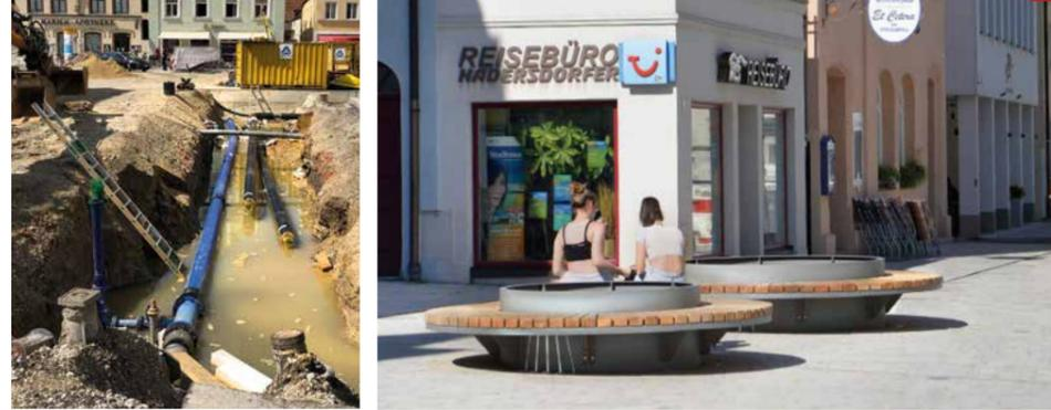
Kompliziertes Unterfangen: Mithilfe eines Dükers wird die Bahnhofstraße unterquert, um dort die Wärmenetzleitung weiterführen zu können (Bild links). In der Oberen Altstadt werden noch Bäume gepflanzt, auch inmitten der Rundbänke am westlichen Ende der Oberen Hauptstraße. Massive Stahlvorrichtungen sorgen dafür, dass die Bäume und ihr Wurzelwerk geschützt sind und sich entfalten können.
